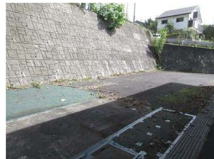
写真2 発電所建設予定地
