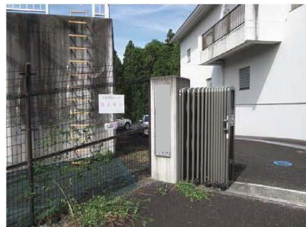
写真1 発電所建設予定施設
