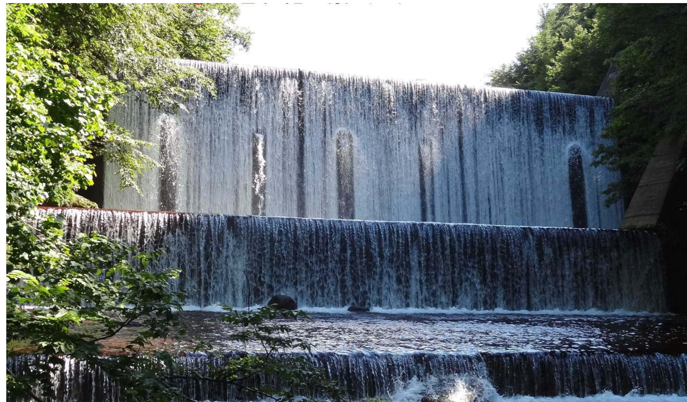
中道堰堤現況写真
