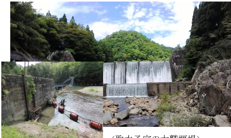
〈取水予定の大鷲堰堤〉
