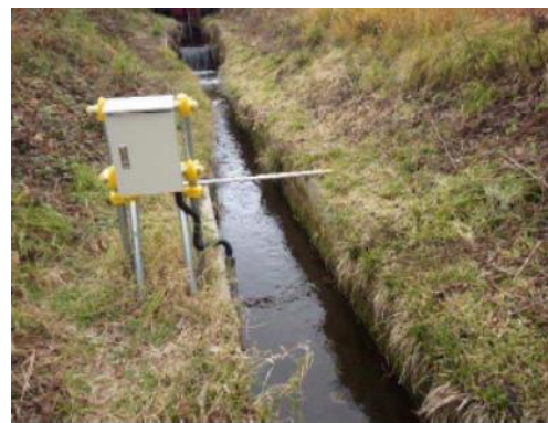
水位計設置状況
