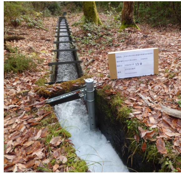
水位計設置状況
