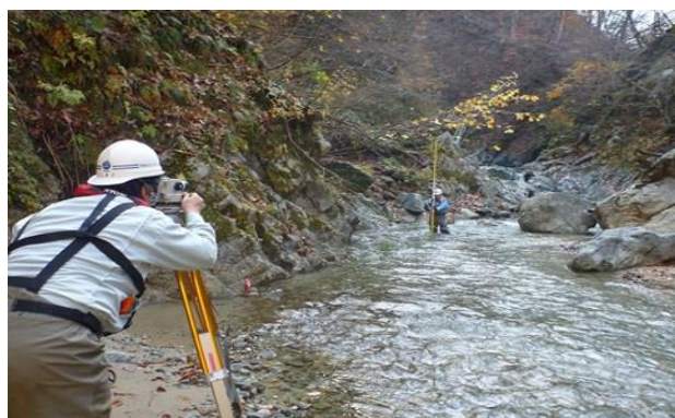
(正常流量調査) 河川横断測量状況
