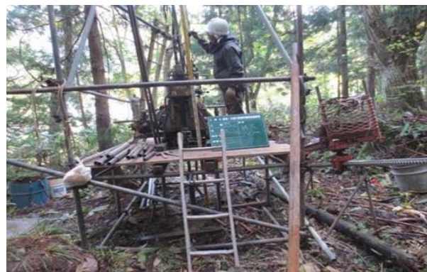
地質調査実施状況
