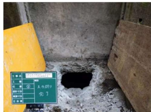
トンネル坑口の開口作業
