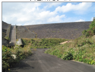
木之川内ダム
