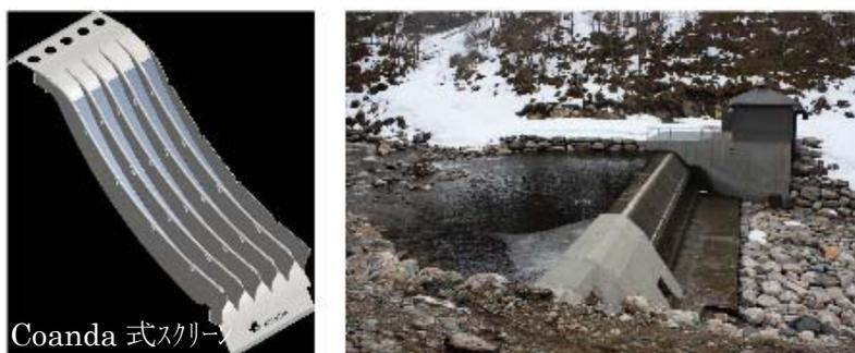
洪水で発生する氷塊や漂流堆積物および流木による摩耗や、機械的な影響からスクリーンを保護することを目的とし、新しく‘Fossekalen’式取水口が開発された。これは、表面を覆う傾斜式スクリーンによって、チロリアン式取水口とCoanda式スクリーンの長所を取り入れたものとなっており、現在では5カ所で‘Fossekalen’式取水口が運用中である。傾斜式スクリーンとしてシュノーケルという装置を取り付けることで漂流物による摩耗を防ぐとともに、スクリーン頂部からの温度変化を防ぐことで、スクリーンに到達した流水の温度を極低温のまま保持することができる。水温保持の原理は、シュノーケルの水面から1m下の位置に穴を設け、そこから取水口水面よりも1/1000℃程度低い水温の水を取り込む。さらに、シュノーケルの天蓋を、熱放射を減少させる構造とすることで温度変化を抑制する。シュノーケルの第1号は2015年にDyrkorn取水口に据付けられ、これまでに有望な結果をもたらしているが、プロトタイプには重大な設計上の問題があることが判明し、問題解決のために今後も実験を通じて最適化していく必要がある。
