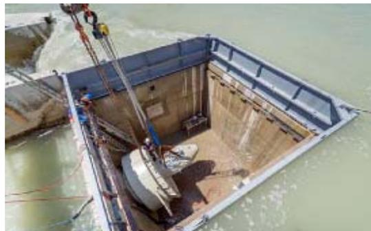
現在、35kW の2つの小型パイロットプラントがある。一つはTUM 理研究所のあるObernach にあり、そこで設計の最適化や生きた魚を用いた試験を実施している。もう一つは、ドイツのHeidenheim で、水車メーカーが建設した実証試験用の発電所である。第1号機は、Bavarian Alps にあるLoisach 川のGrossweil 近傍のNatura 2000 に位置し出力は420kW、2019 年秋に運開予定である。設置場所の認可取得の際には、NGO により、レッドデータブックに載っている鮭と鯀の希少魚類の生息が水力発電所により危険にさらされるのではないかと訴えが出たが、TUM で実証中の試験から得た知見で反論した結果、魚の生息を脅かすのは発電運用者だけではないということ見解もあったことから結審となった。その後の検討で、魚に与えるダメージは水車を通過するか、バイパス水路を下流方向に移動するかにより生じるもので、概ね2.5%という予測が得られた。
