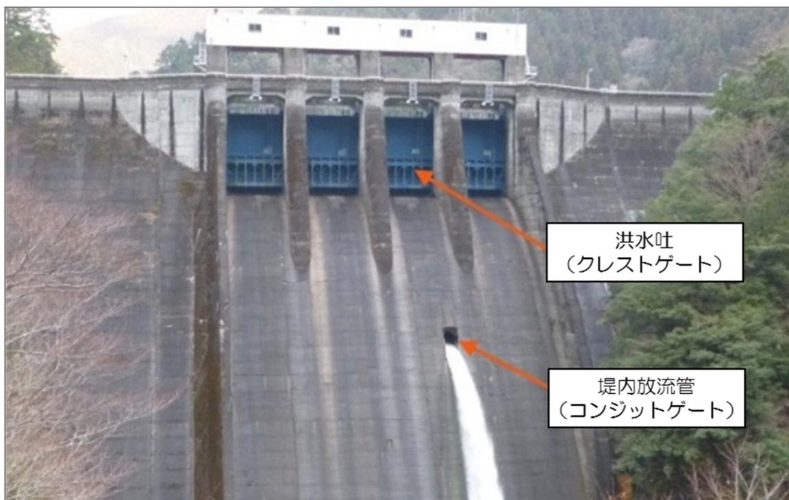
図 3.3-3 算出区分 A-2 方式に分類されるダムのイメージ
