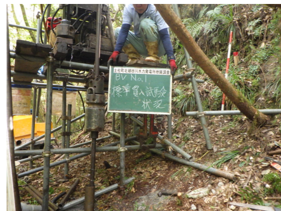
地質調査 標準貫入試験
