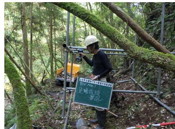
地質調査 足場仮設状況
